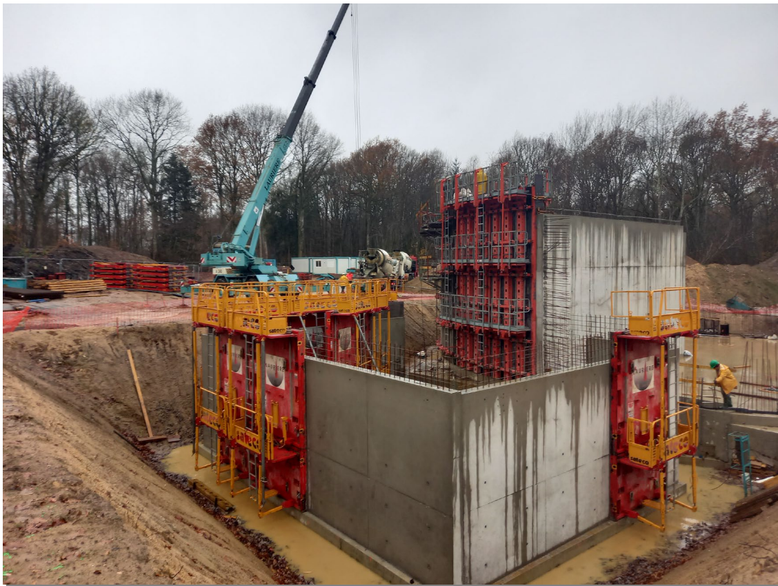
Construction de la bête de 2 000 m 3 au Bas MORY – commune de FEYTIAT
