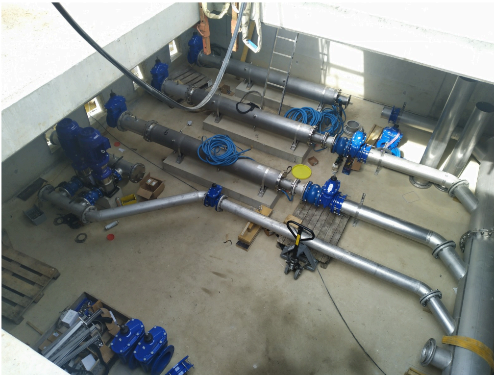
Travaux en cours sur la station de reprise - bache du Bas Mory - commune de FEYTIAT
