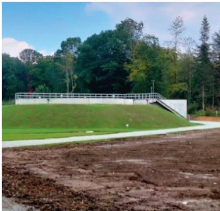
FEYTIAT - Le Bas Mory Construction d'une bache de stockage de 2000 m 3
