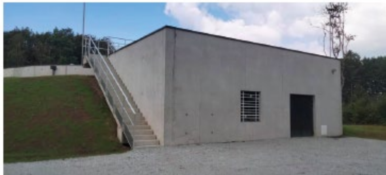
FEYTIAT - Le Bas Mory Construction d'une bache de stockage de 2000 m 3
