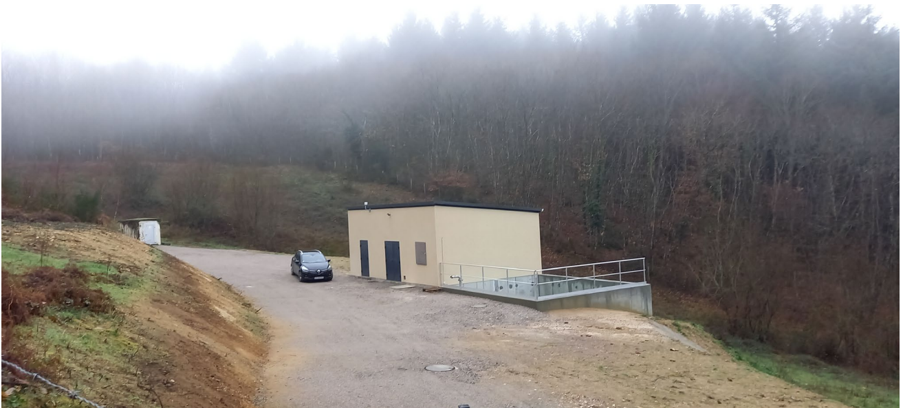
Station de neutralisation de FONT l'HERMITTE à RILHAC LASTOURS
