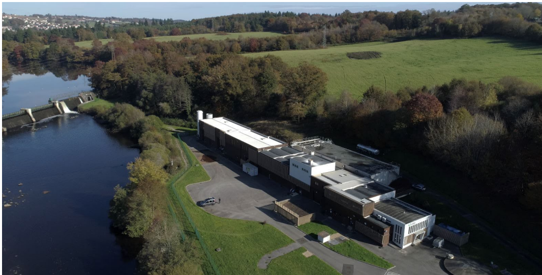
Vue du ciel de la station de PANAZOL
