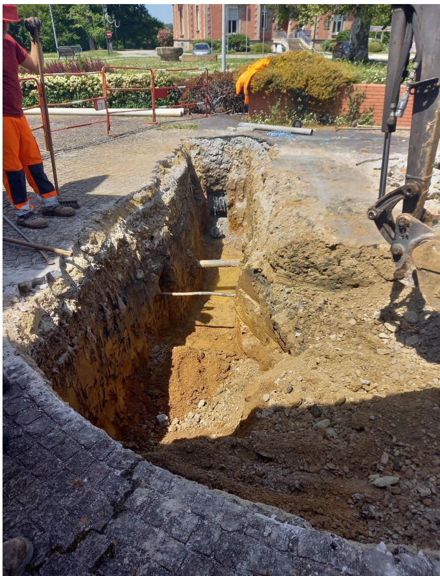
PANAZOL - Avenue Jean MONET, Avenue Pierre GUILLOT et Rue MARECHAL JOFFRE Renforcement réseau AEP en PVC Ø 200mm sur 320 ml
