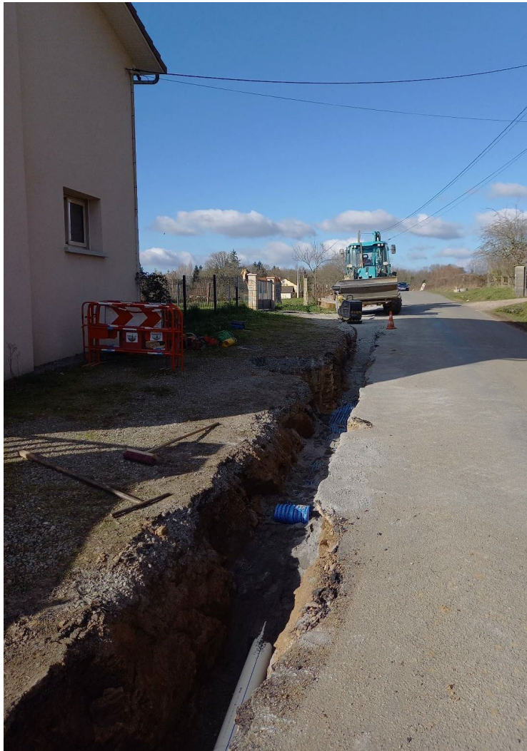
CHAILLAC SUR VIENNE – RD86A Renouvellement de conduites en PVC Ø 160mm sur 1 230ml
