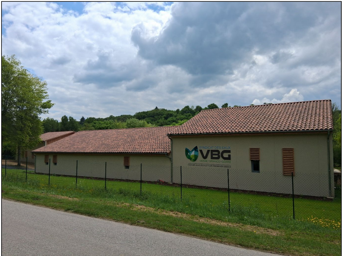
Station de traitement de SOLIGNAC
