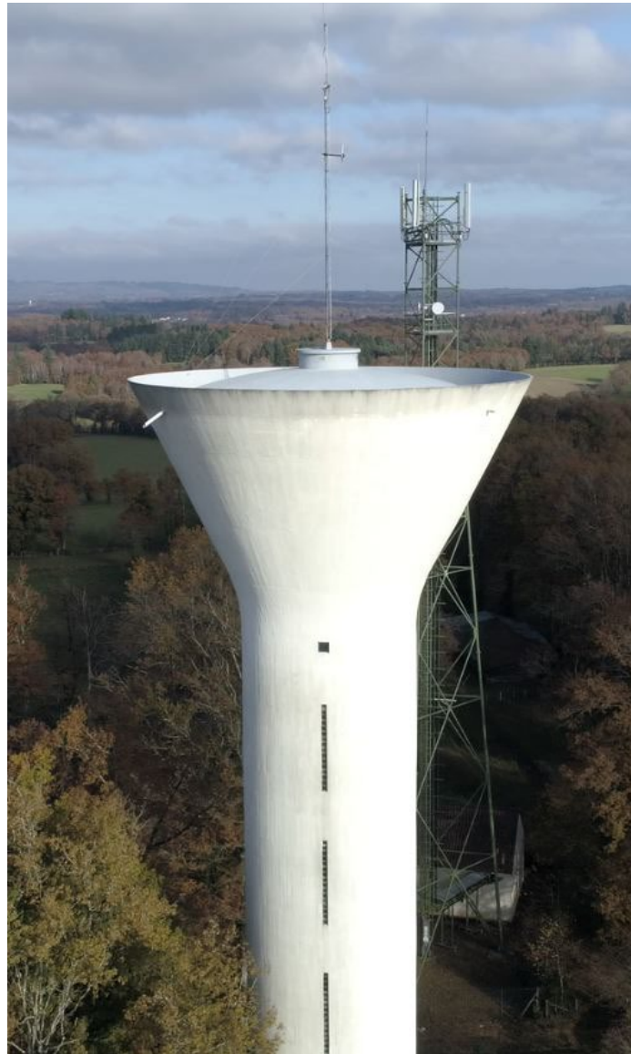
Réservoir de la BARRE Commune de VEYRAC (Vue du Ciel)
