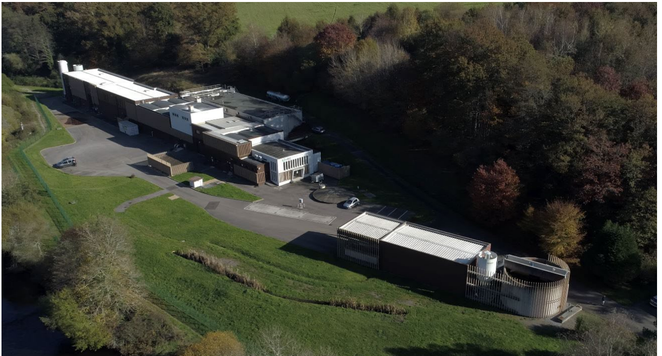
Station de traitement de PANAZOL (Vue du Ciel)
