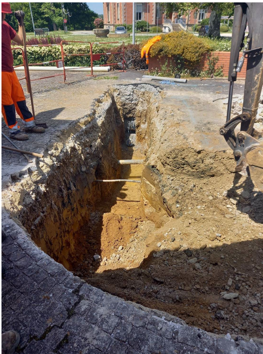
PANAZOL - Avenue Jean MONET, Avenue Pierre GUILLOT et Rue MARECHAL JOFFRE Renforcement réseau AEP en PVC Ø 200mm sur 320 ml
